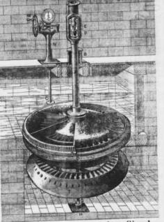
Turbine hydraulique système Girard ayant un rendement constant jusqu'.u. 1/4 du débit total convenant seule pour débits variables.
